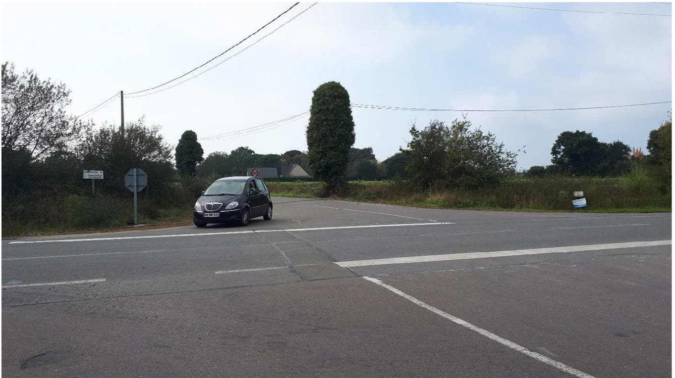
Figure 2a : Vue vers la voie communale à l'ouest vers la Ville au Coq
